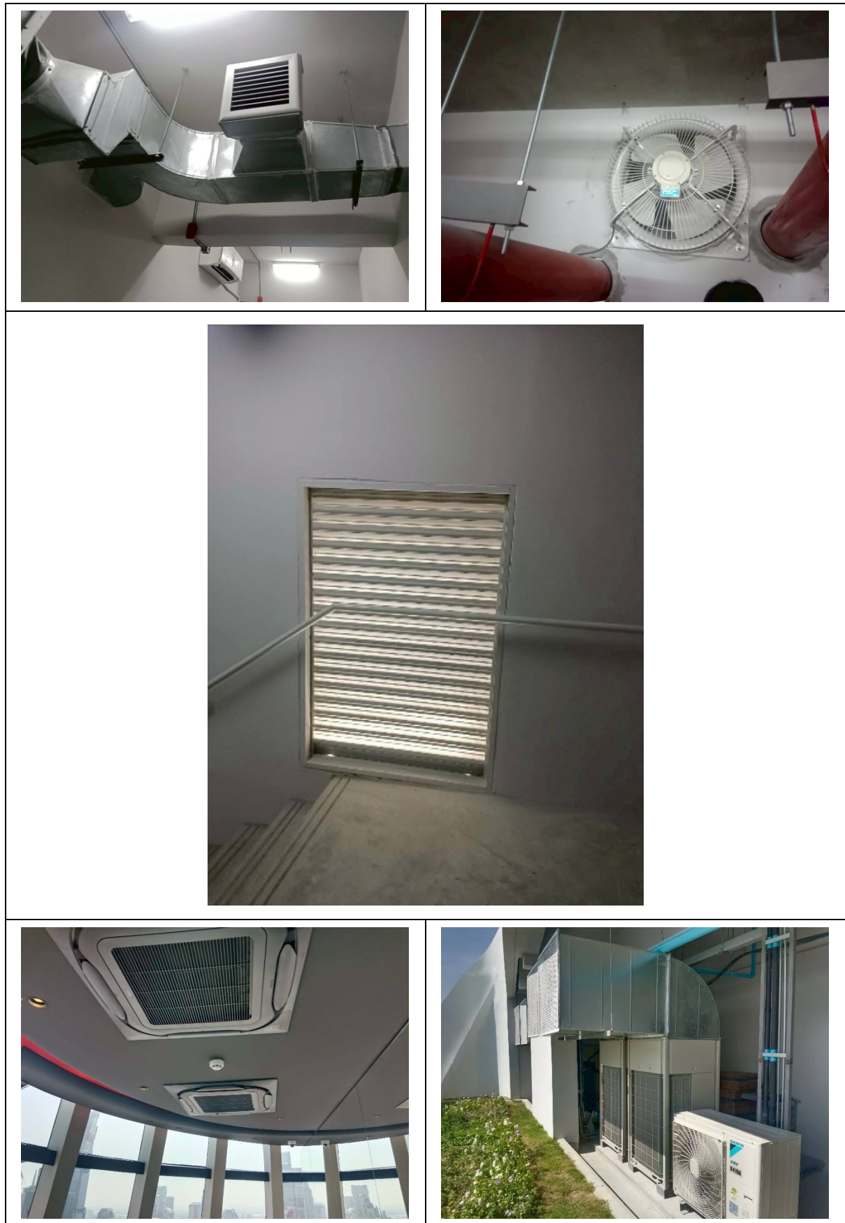
ภาพที่ 1.3.9-1 ระบบปรับอากาศและระบายอากาศของโครงการ
